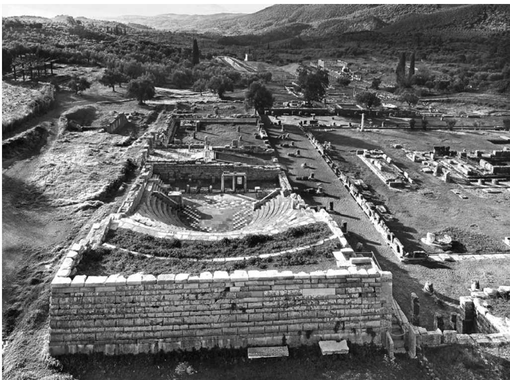
Εἰκ. 7α. Συμπλήρωση κυψωτοῦ ἀναλήμματος Ἐκκλησιαστηρίου.
