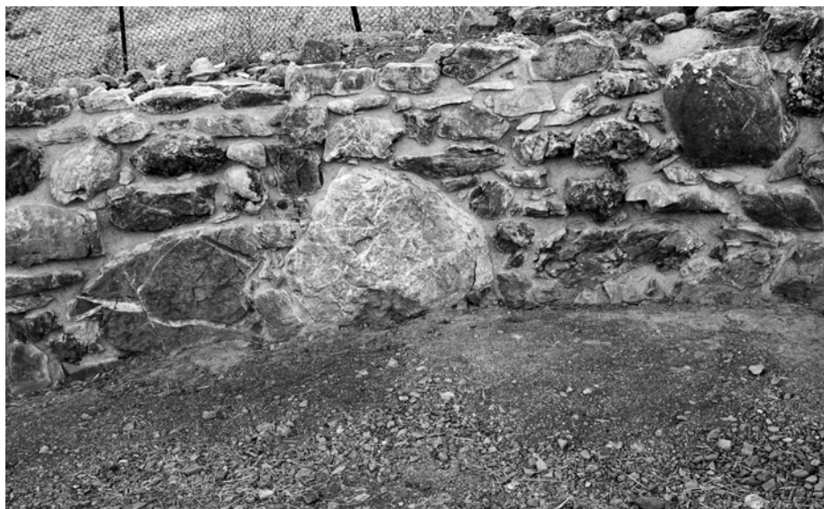
Εἰκ. 5. Τμήμα τῆς ἐσωτερικῆς ὀψης τοῦ κυκλικοῦ τοίχου τοῦ θολωτοῦ τάφου Ε μετὰ τὶς ἐργασίες στερέωσης.
