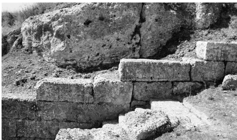
Εἰκ. 8. Τεμάχια ἀπὸ τῆ δωρική ζωφόρο τῆς β' οἰκοδομικῆς φάσης τοῦ ἄνω ἀνδῆρου ἐντοιχισμένα στὸν νότιο τοῖχο τοῦ γυμνασίου, κατὰ μῆκος τῆς (μεταγενέστερης) κλίμακας (λήψη ἀπὸ Β.).
