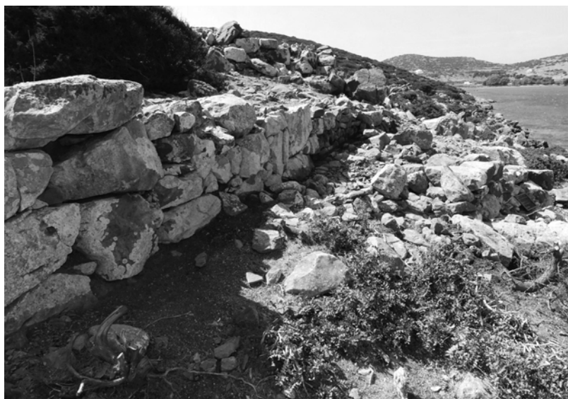
Είκ. 12. Τὸ Μεγάλον Ἀνάλημμα καὶ ὁ Δυτικός Τριγωνικός Πρόβολος μετὰ τὸν καθαρισμό, λήψη ἀπὸ ΒΑ.
