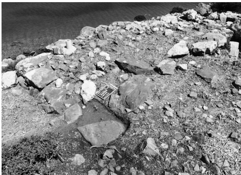
Εἰκ. 13. Ὁρθογώνιο Οἰκοδόμημα. Ὁ καθαρισμὸς τοῦ στιβαροῦ δυτικοῦ τοίχου ἐνισχύει τὴν ἐκτίμηση ὅτι πρόκειται γιὰ κτίριο ἀμυντικῆς χρήσης, ἴσως πύργο.
