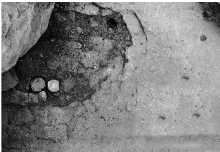
Εἰκ. 46. Τομή 13. Τὸ ψηφιδωτὸ τοῦ βόρειου κλίτους εἶχε καλυφθεῖ ἀπὸ σκληρὸ ἀσβεστοκονίαμα, πιθανὸν λόγῳ ἐκτεταμένης φθορᾶς τοῦ ἢ σὲ μεταγενέστερη φάση, ὅταν ὁ χώρος αὐτὸς δὲν ἦταν πλέον στεγασμένος.
