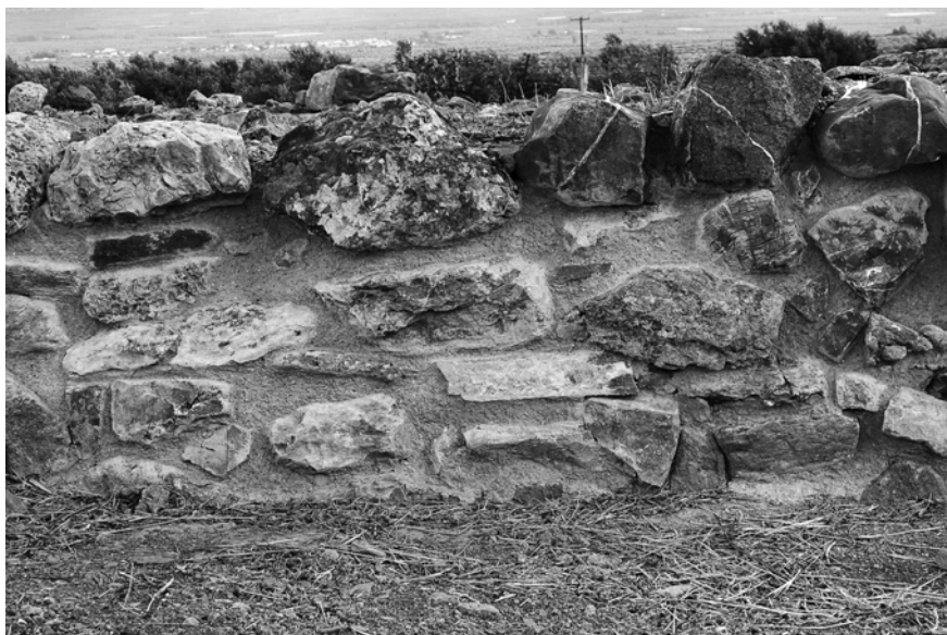
Εἰκ. 8. Τμῆμα τῆς ἐσωτερικῆς ὀψης τοῦ κυκλικοῦ τοίχου τοῦ θολωτοῦ τάφου Β μετὰ τίς ἐργασίες στερέωσης.
