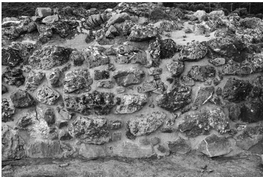
Εἰκ. 7. Τμῆμα τῆς ἐσωτερικῆς ὀψης τοῦ κυκλικοῦ τοίχου τοῦ θολωτοῦ τάφου Β μετὰ τίς ἐργασίες στερέωσης.
