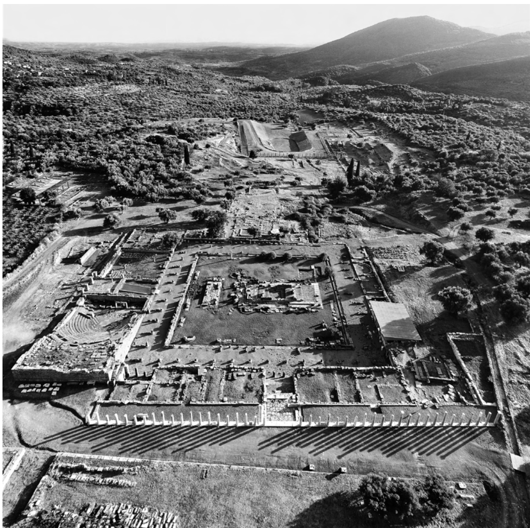
Εἰκ. 7β. Γενικὴ ἄποψη τοῦ Ἐκκλησιαστηρίου ἀπὸ Β. μετὰ τὴν ἀναστήλωση τοῦ ἄνω κοίλου καὶ τοῦ κλιμακοστασίου.
