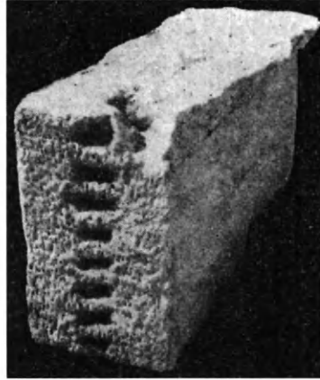
Εἰκ. 71. Διαδοχικὰ ἐπάλληλα μοχλοβόθρια ἐπὶ μεταδοκίῳ πλακῶς τοῦ Παρθενῶνος.
