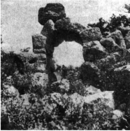
Εἰκ. 354. Ἡ ὑπ' ἀριθ. 7 πύλη τοῦ τείχους τῶν Οἰνιαδῶν καλυπτομένη διὰ κλειδωτοῦ ἡμικυκλικοῦ τόξου (Powell).
