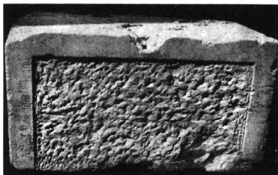
Εἰκ. 131. Ἀναθύρωσις πλάτους 0.08 μ. ἐπὶ λίθου τῶν τοίχων τῶν Προπυλαίων.
