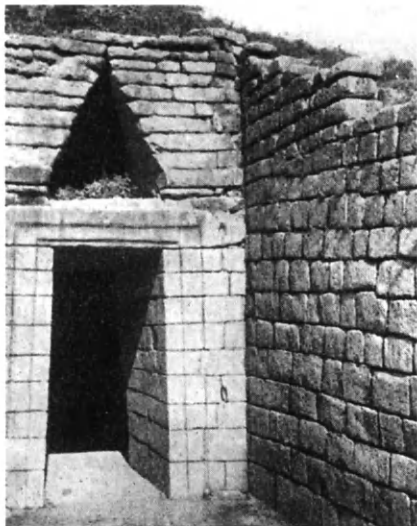
Εἰκ. 245. Τὸ στόμιον τοῦ ἐν Μυκῆναις θησαυροῦ τοῦ Ἀτρείως μετὰ τὰ κεκλιμένα τοιχώματα αὐτοῦ καὶ τὸ τριγωνικὸν ἐκφορικὸν ἀνακουφιστικὸν τόξον τοῦ δριζοντίου ὑπερθύρου του.
