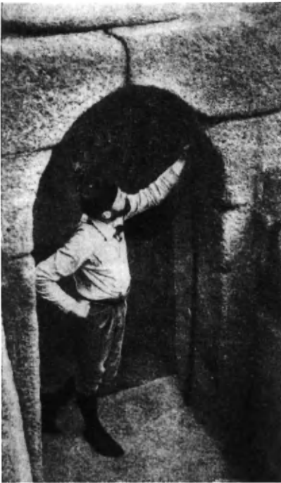
Εἰκ. 353. Πύλη τοῦ τείχους τῆς Ἀσσου μετὰ διλιθικοῦ ὑπερθύρου καὶ ἐκφορικῶν γεννήσεων (Clarke).
