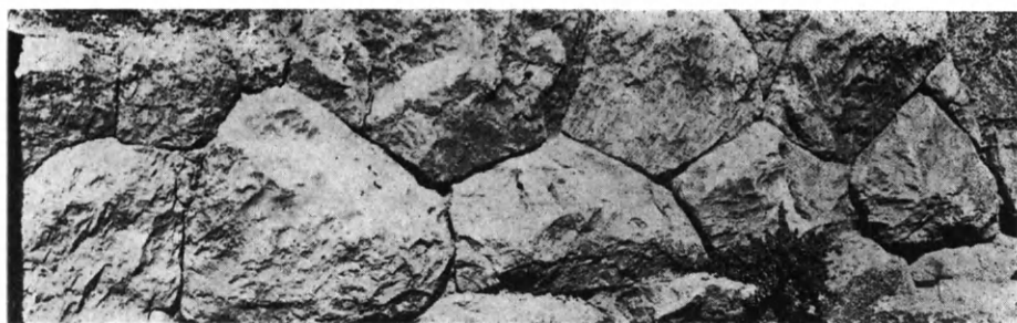
Εικ. 204. Λεσβία δομή με φυσικήν ὄψιν τῶν λίθων καὶ εἰργασμένους μόνον τοὺς ἀρμούς. Βάσις τοῦ πεισιστρατείου τείχους τῆς Ἑλευσίνος.
