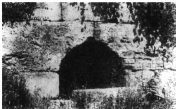
Εἰκ. 349. Πυλὶς τοῦ τείχους τῆς ἐν Κάτω Ἰταλίᾳ Ποσειδωνίας μετὰ διλιθικοῦ ὑπερθύρου (Lugli).
