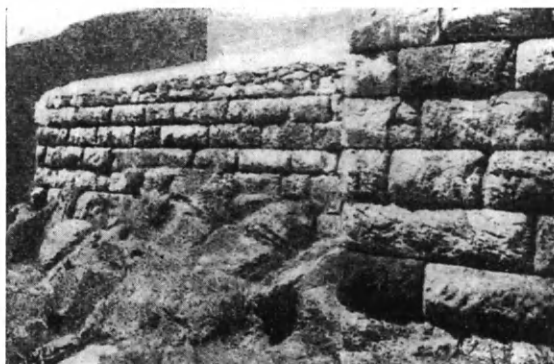
Εἰκ. 211. Τεῖχος μετὰ λίθους κατὰ τὸ ἀγροτικὸν σύστημα ἦτοι μετὰ σφυροκοπημένην ἐπιφάνειαν. Λέρος (Dawkins - Wace).
