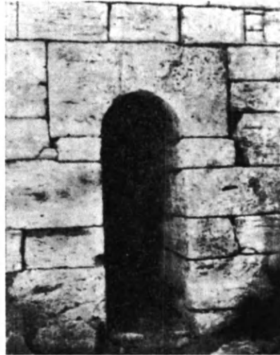
Εἰκ. 344. Τοξωτὸν ἀνοιγμα ἀναλήμματος τοῦ θεάτρου τῆς ἐν Σικελίᾳ Αἰγέστης μετὰ μονολιθικοῦ ὑπερθύρου (Lugli).
