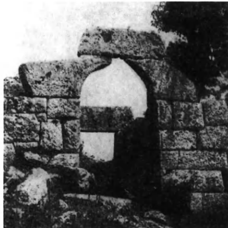
Εἰκ. 346. Πύλη τοῦ τείχους τῆς ἐν Ἀκαρνανίᾳ Μητροπόλεως (Παλαιομάνινας) μετὰ διλιθικοῦ τοξωτοῦ ὑπερθύρου (Noack).
