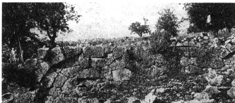
Εικ. 208. Πολυγωνικὸν τεῖχος Παλαιῶν τῆς Ἀχαρνῆς με βελονιασμένην τὴν ἐξωτερικὴν ἐπιφάνειαν τῶν λίθων (Noack).
