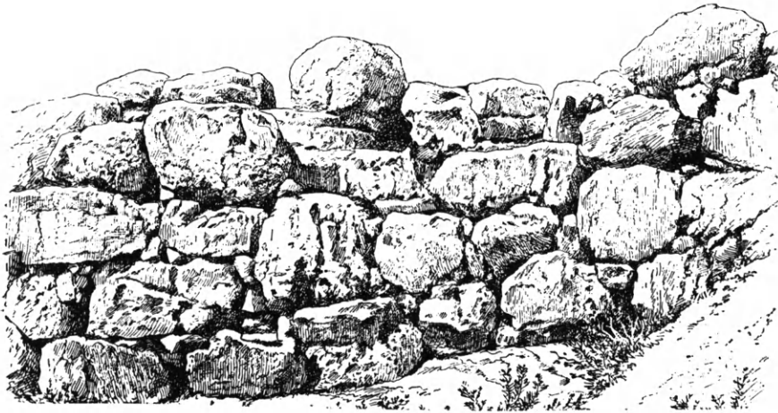
Εἰκ. 203. Δεῖγμα κυκλωπείου μυκηναϊκῆς τειχοδομίας ἐκ τῆς Ἀκροπόλεως τῶν Ἀθηνῶν, εὐρισκόμενον ὀπισθεν τοῦ Μουσείου (Dörpfeld).
