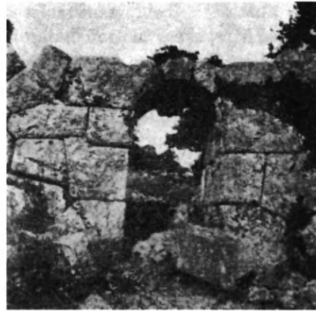
Εἰκ. 355. Ἡ ὑπ' ἀριθ. 3 πύλη τοῦ τείχους τῶν Οἰνιαδῶν καλυπτομένη διὰ κλειδωτοῦ ἡμικυκλικοῦ τόξου (Powell).
