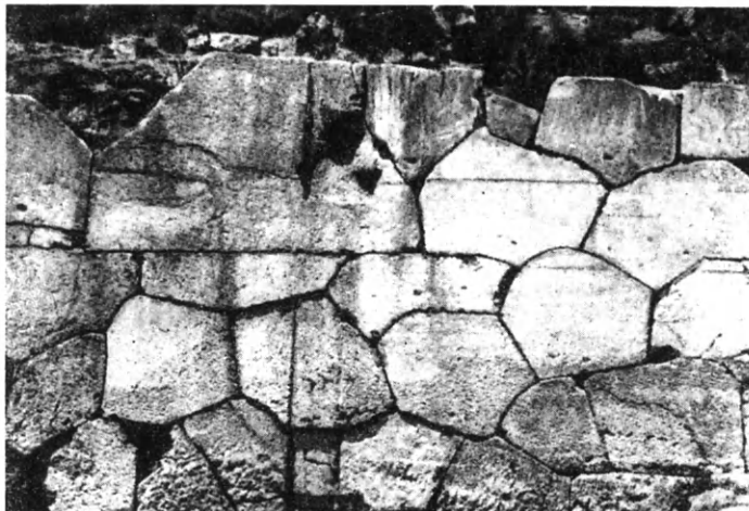
Εἰκ. 169. Τμήμα τοῦ ἀναλήμματος τοῦ ἐν Δελφοῖς ναοῦ τοῦ Ἀπόλλωνος. Δεῖγμα λεσβίας δομῆς.
