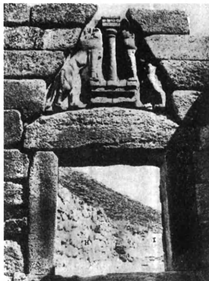
Εἰκ. 246. Τὸ μετὰ καμπύλης ράχεως ὀριζόντιον ὑπερθύρον τῆς ἐν Μυκῆναις πύλης τῶν λαινῶν.
