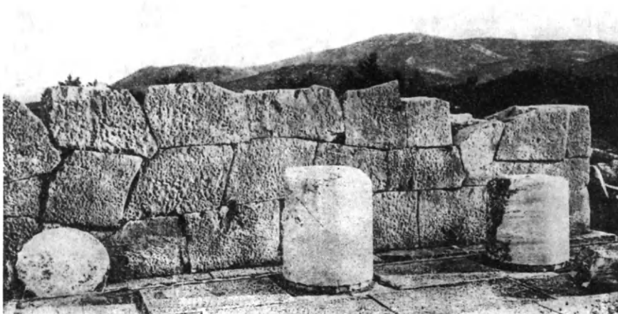
Εἰκ. 167. Τοῖχος τοῦ ἀρχαιότερου ναοῦ τοῦ Ραμνοῦντος. Λεσβία δομή. (Φωτογρ. Γερμανικοῦ Ἀρχαιολογικοῦ Ἰνστιτούτου).
