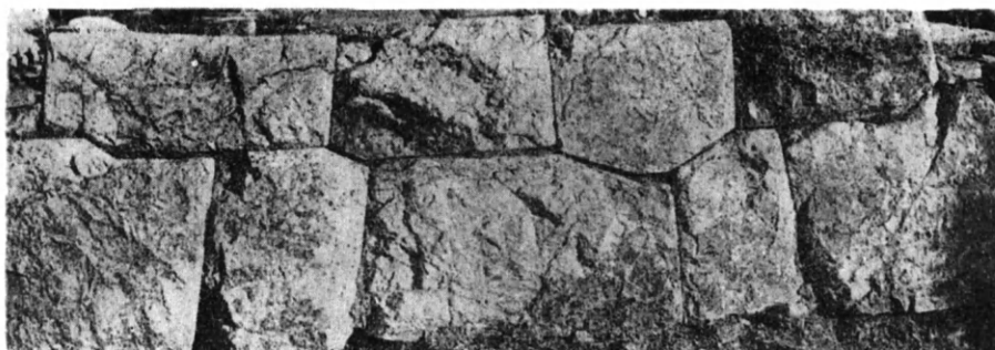
Εικ. 207. Πολυγωνικὸν με φυσικὴν ὄψιν τῶν λίθων καὶ σφυροκοπημένους τοὺς ἄρμους. Νότιον τεῖχος τοῦ Ἀσκληπείου τῶν Ἀθηνῶν.
