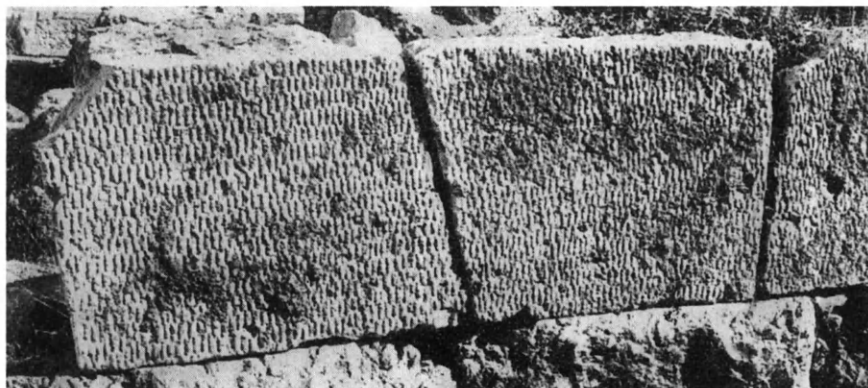
Εἰκ. 224. Ἀθῆναι, Ἀσκληπιεῖον, Νότιον τεῖχος. Ἰσόδομον τραπεζιόσχημον μετὰ πυκνῶν μικρῶν λαξευμάτων δι' ὁδοντωτῆς ξοῖδος.
