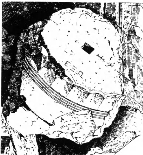
Εἰκ. 111. Τεκτονικὸν σῆμα ἐπὶ τοῦ ὑποτραχηλίου τοῦ κιονοκράνου τοῦ ἐν Θήβαις ναοῦ τοῦ Ἰσμηνίου Ἀπόλλωνος. (Σχέδιον Α. Ζάχου)
