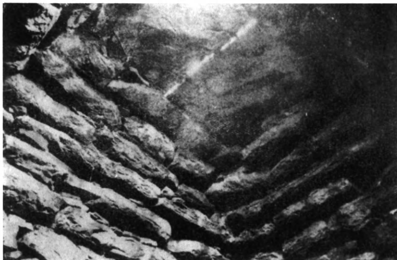
Εἰκ. 313. Ἑσωτερικὴ ὄψις τοῦ ἐν Ὁράκ-Μπουκὶ τῆς Καρίας θαλαμοειδοῦς τάφου καλυπτομένου δι' ἐκφορικοῦ πυραμιδοειδοῦς θόλου (Maiuri).
