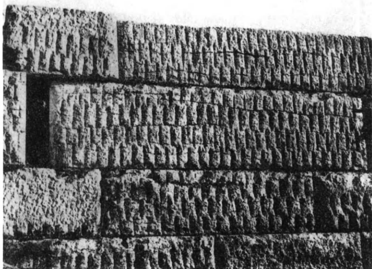
Εἰκ. 223. Τὸ ὀχυρωματικὸν τεῖχος τῆς πόλεως τῆς Μεσσήνης. Ἰσόδομον μετὰ κατακορύφων διακοσμητικῶν βελονιῶν (Ὁρλάνδος).
