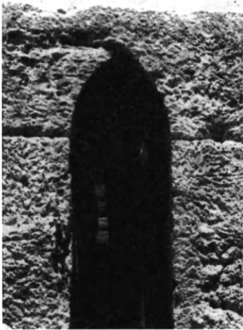
Εἰκ. 343. Πυλὶς τείχους Ἀπολλωνίας τῆς Ἰλλυρικῆς μετὰ μονολιθικοῦ ἐσκαμμένου ὑπερθύρου.
