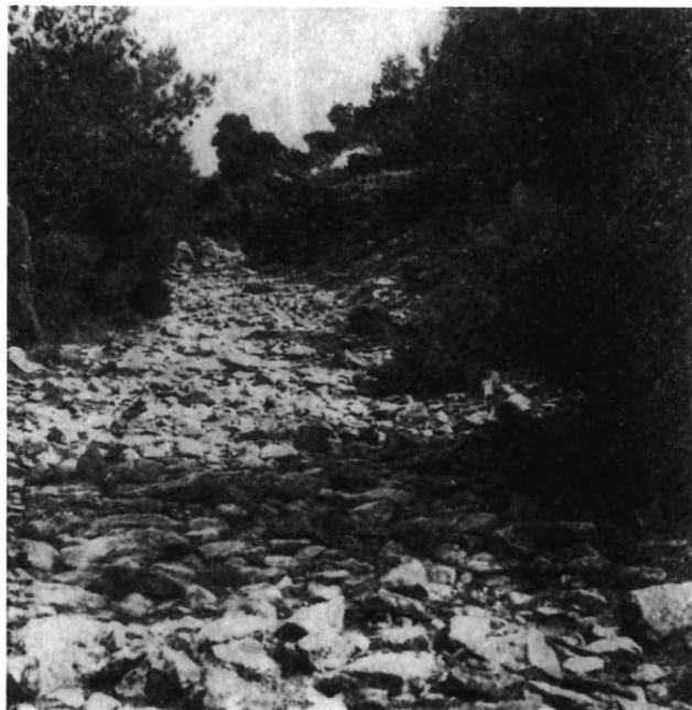
Εἰκ. 31. Σημερινὴ ὄψις τοῦ ἀρχαίου κατωφεροῦς δρόμου καταβιάσεως τῶν μαρμάρων ἐκ τοῦ Πεντελικοῦ (φωτογρ. 'Α. 'Ορλάνδου).
