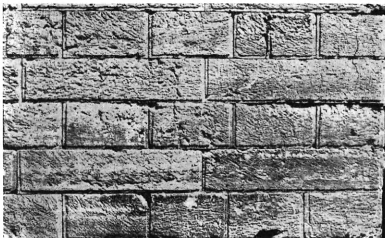
Εἰκ. 233. Ἡ ἐσωτερικὴ ὄψις τοῦ περικλείου τείχους τῆς Ἑλευσίνος μὲ τούς λίθους ἐναλλάξ παρὰ μήκος καὶ διατόνους
