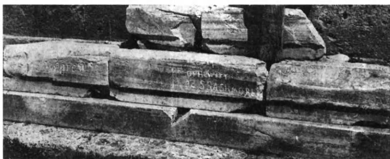
Εἰκ. 235. Αἱ μετ' ἀπέργου καὶ κυματοφόρου ὑποτομῆς βαθμίδες τοῦ ἐν Σουνίῳ ναοῦ τοῦ Ποσειδῶνος (Ὁρλάνδος).
