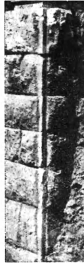
Εἰκ. 228. Λάξεις διὰ ξοῖδος τῆς ἀκμῆς τοῦ ἀναλήμματος τοῦ θεάτρου Πριήνης (Schrader).
