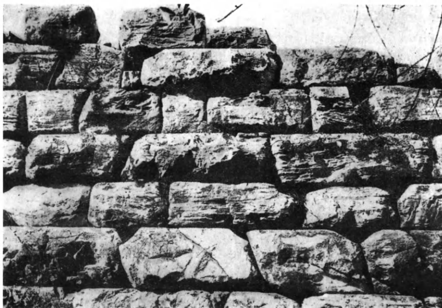
Εἰκ. 178. Ραμνοῦς. Ἰσόδομον τραπεζιόσχημον με ἐπιφάνειαν λατομείου (Wrede).
