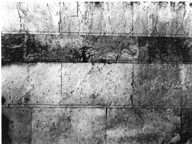
Εἰκ. 230. Τμήμα τοῦ θεμιστοκλείου τείχους τῆς Ἀκροπόλεως παρουσιάζον τοὺς λίθους μὲ συνεχὴ ταινίαν εἰς τὸ κάτω μέρος των.
