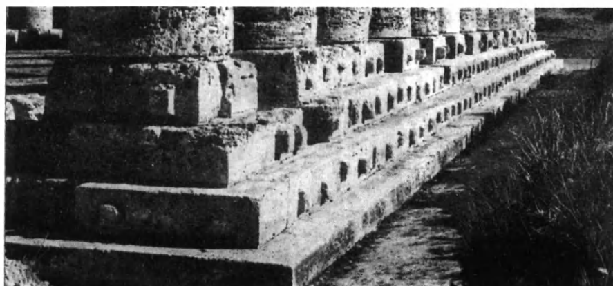
Εἰκ. 114. Ἡ κρηπίς τοῦ ἡμιτελοῦς ναοῦ τῆς Αἰγέστης, πλήρης ἀγκῶνων ἀννψώσεως τῶν λίθων της.
