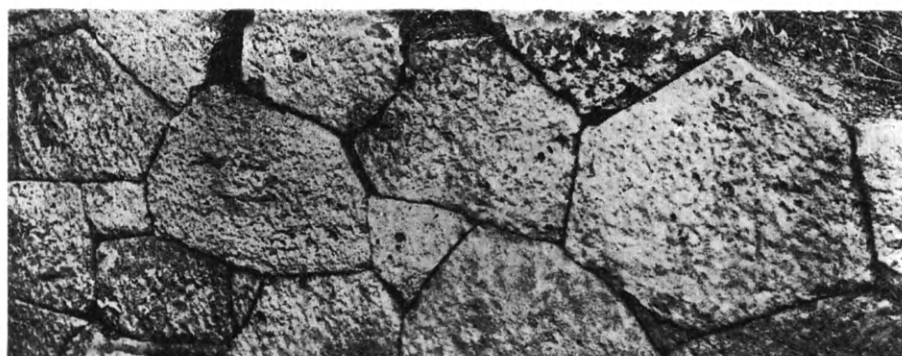
Εικ. 205. Λεσβία δομή με βελονιασμένην τὴν ἐπιφάνειαν τῶν λίθων. Δεξαμενὴ νοτιάς κλιτύος τῆς Ἀκροπόλεως τῶν Ἀθηνῶν.
