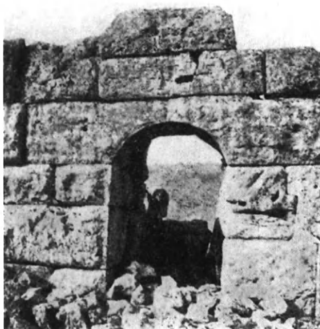
Εἰκ. 348. Πύλη τοῦ τείχους τῆς ἐν Ἀκαρνανίᾳ Λιμναίας (Κραβασαρά) μετὰ διλιθικοῦ, ἐλαφρῶς χαμηλωμένου τοξοῦ τοῦ ὑπερθύρου (Powell).
