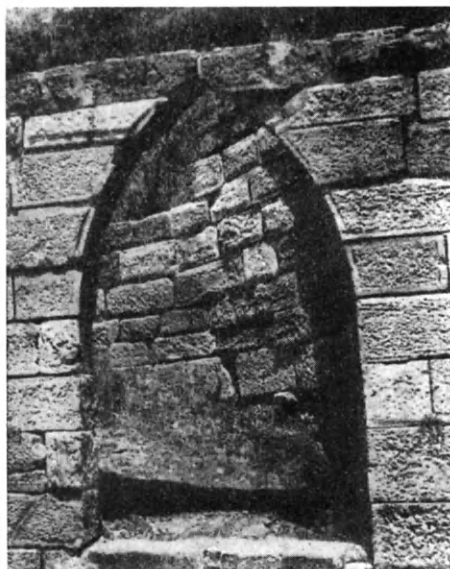
Εἰκ. 319. Πύλη τείχους τῆς ἐν Β. Ἡπείρῳ Ἀπολλωνίας μὲ ὀξυκόρυφον ἐκφορικὸν τόξον.
