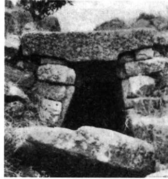
Εἰκ. 321. Ὑπόνομος ὁδοῦ τῆς Περγάμου μετ' ὑπερθύρον ἐμβολοειδὲς (Böhringer).
