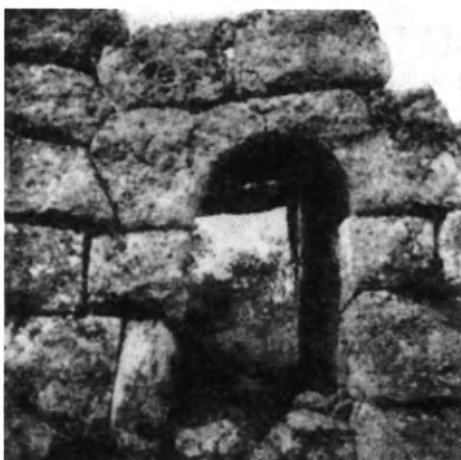
Εἰκ. 345. Ἡ πύλη ὑπ' ἀρ. 10 τοῦ τείχους τῶν Οἰνιαδῶν καλυπτομένη διὰ διλιθικοῦ τοξωτοῦ ὑπερθύρου (Powell).
