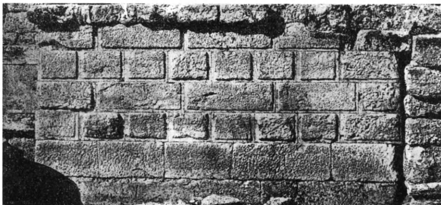
Εἰκ. 214. Πύργος τοῦ Διπύλου. Ἰσόδομον σύστημα, μὲ λίθους φέροντας περιτένειαν περιβάλλουσιν ἀνώμαλον ἑξεργον ἐσωτερικὴν ἐπιφάνειαν.
