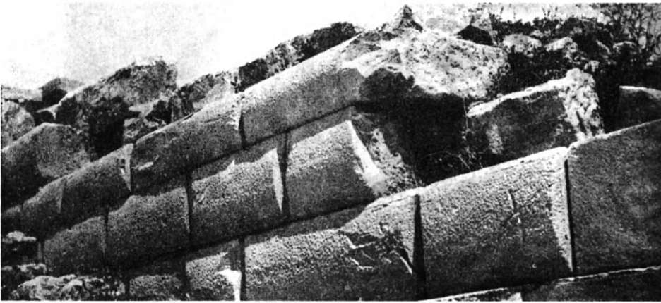
Εἰκ. 226. Ἑκκλησιαστήριον τῆς Πριήνης (περὶ τὸ 200 π.Χ.). Τοῖχος μετὰ λίθους λαξευμένους ὁμαλῶς ἐν εἴδει προσκεφαλαίου καὶ μετὰ λοξὴν τμήσιν ἐκατέρωθεν τῶν κατακορύφων ἁρμών.
