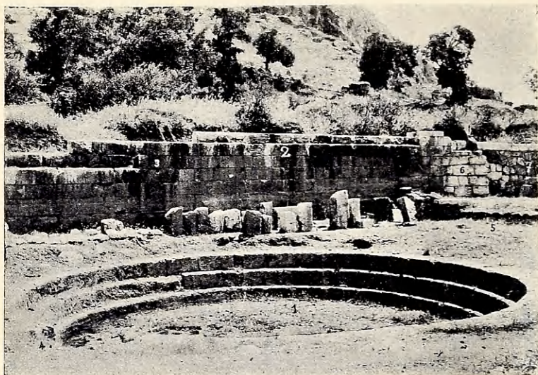
Εἰκ. 44. Τὸ λουτρὸν τοῦ γυμνασίου. (1) περιφερὴς δεξαμενὴ πρὸς κολύμβησιν. (2, 3) στόμια κρηνῶν. (4) θέσις ἐκλιπούσης κλίμακος (ὁ ἀνώτατος λίθος ἀποτετριμμένος). (5) τὸ πολυγωνικὸν ἀνάλημμα τῆς παλαίστρας ἔχον στόμιον παλαιότερας κρήνης.
