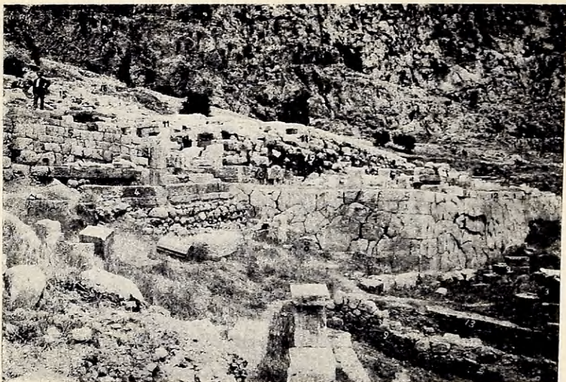
Εἰκ. 20. Ὅψεις ἀπὸ δυσμῶν. Ἐμπρὸς δεξιὰ (9) ὁ παλαιὸς περιβόλος. (13) παλαιὸν ὕδραγωγεῖον. (2) γωνία πωρίνου κτιρίου τμηθεῖσα ὑπὸ τοῦ πολυγωνικοῦ ἀναλήμματος ἔχοντος ἄνω εὐθυγράμους δόμους πωρίνους (12) τὸ δὲ ἐν τῇ γῇ ποτὲ κρυπτὸν ταπεινὸν μέρος (8) ἀδρότερον εἰργασμένον. Ὑπεράνω εἶνε (19) τὰ κρηπιδώματα τοῦ ναοῦ. Ἀριστερὰ (4.5) πώρινα λείψανα δύο καλυφθέντων μετὰ τὸ 548 θησαυρῶν πιθανῶς.
