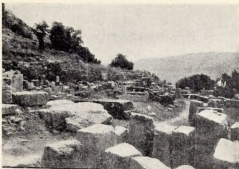
Εἰκ. 43. (1) πολυγωνικὸν ἀνάλημμα ὑπὸ τὴν παραδρομίδα, ὑπὲρ τὴν παλαίστραν. (2) ἰσοδομικὸν ἀνάλημμα καὶ κλίμαξ. (3-6) τοῖχοι τῆς παλαίστρας.
