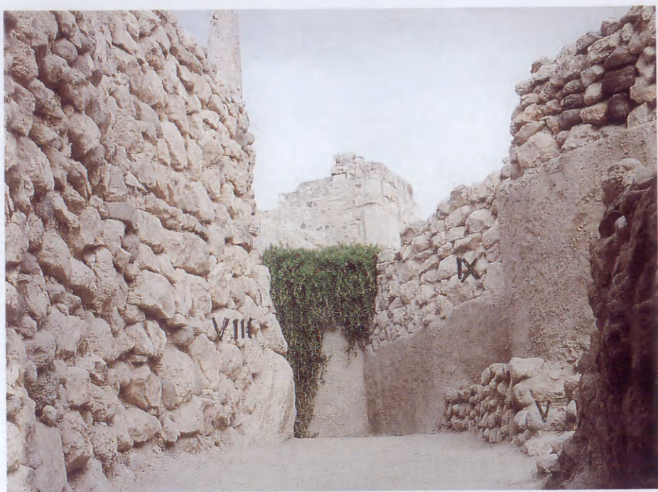
Εικ. 78. Μεγάλο όχυρωματικό τείχος στη νότια πύλη του όγδοου χωριού. Πέμπτο καί ένατο τείχος. Από νότια.
