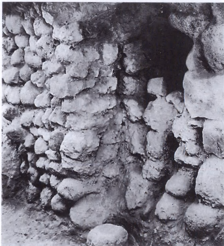
Είκ. 85. Έσωτερικὸ τοῦ δρόμου τῆς πύλης: δεξιὰ πλευρὰ τῆς πύλης μετὰ τὸ ἄνοιγμα γιὰ τὸν σύρτη· κάτω ὁ πέτρινος ἀρμός γιὰ τὸ περιστρεφόμενο δοκάρι τῆς πύλης.
