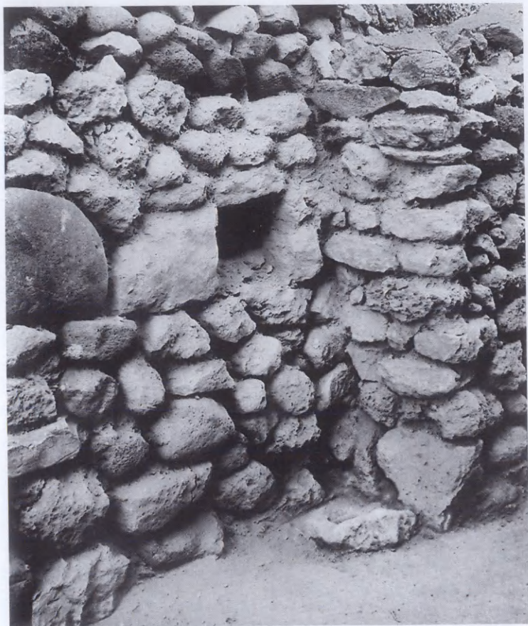
Εικ. 84. Ἐσωτερικὸ τοῦ δρόμου τῆς πύλης: ἀριστερὴ πλευρὰ τῆς πύλης μετ' τὸ ἄνοιγμα γιὰ τὸν σύρτη· κάτω ὁ πέτρινος ἄρμος γιὰ τὸ σταθερὸ δοκάρι τῆς πύλης.
