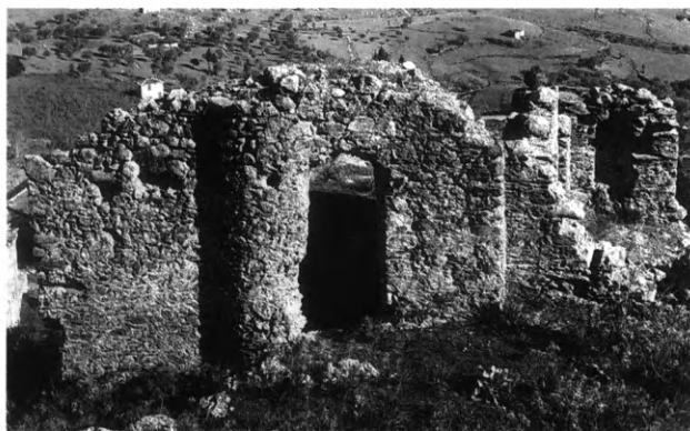
Εἰκ. 53. Σπίτι Φ. Καμπύλη ἐξοχὴ πρὸς οἰκονομίαν ἐσωτερικῆς γυριστῆς κλίμακος (ὄρα κάτωφιν ἐν εἰκ. 50Δ).
