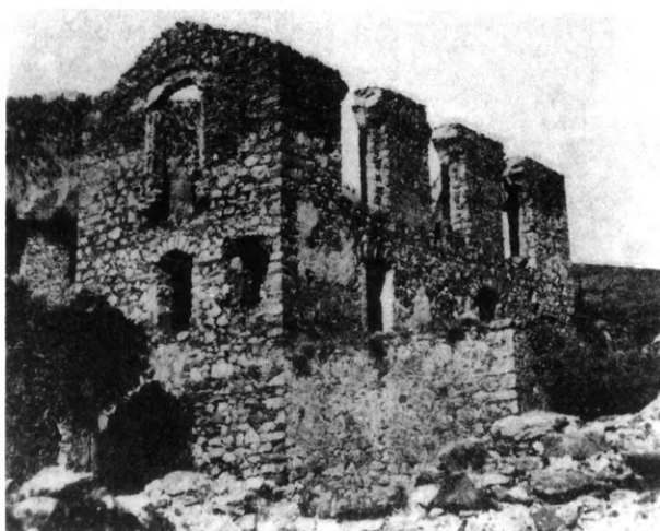
Εἰκ. 93. Σπίτι Γ. Ὑποψις ἀπ' ἀνατολῶν.
