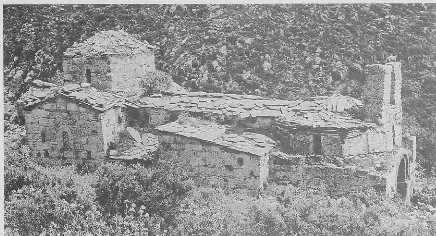
1 Ἡ Β πλευρὰ τοῦ Ἁγ-Στράτηγου Μπουλαριῶν πρὸ τῶν ἐργασιῶν συντηρήσεως.
