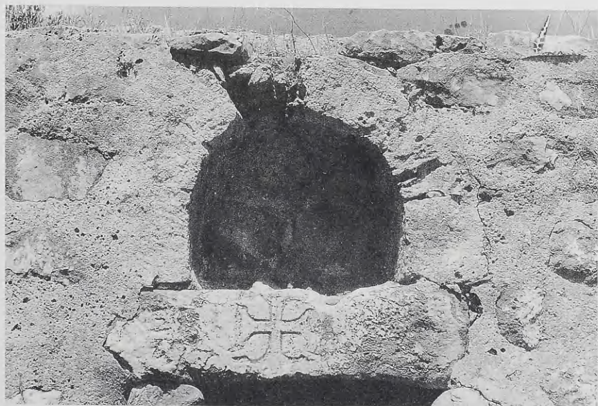
3 Πεταλόμορφο ἀνακουφιστικό τόξο τῆς φραγμένης Ν θύρας.
