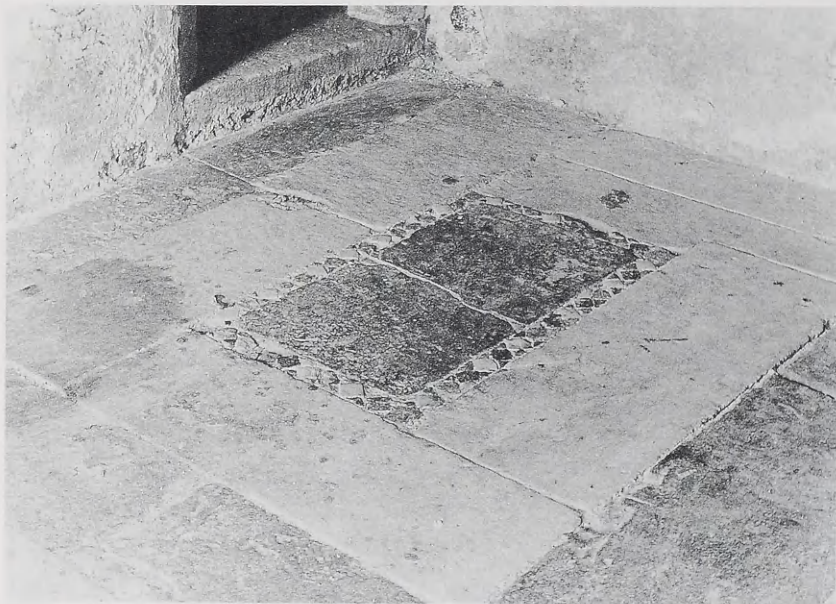
12 Ἀπὸ τὴν πλακόστρωση τοῦ δαπέδου.
